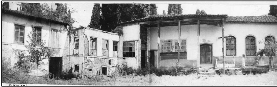
Figure 7b. The Matbah-ı şerif section, the Meydanı- şerif and the Türbe-i şerif of the Bursa Mevlevîhâne before 1953 (Tanrıkorur, 2000, 178)
