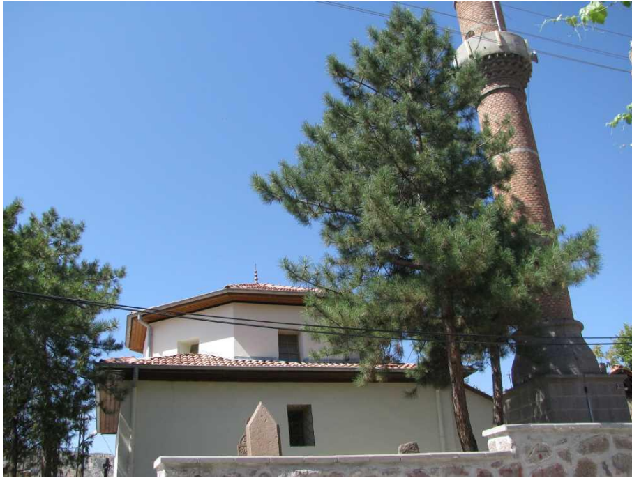
Figure 1. Exterior view of Şeyhoğlu Mosque (Karakuş, 2007)
